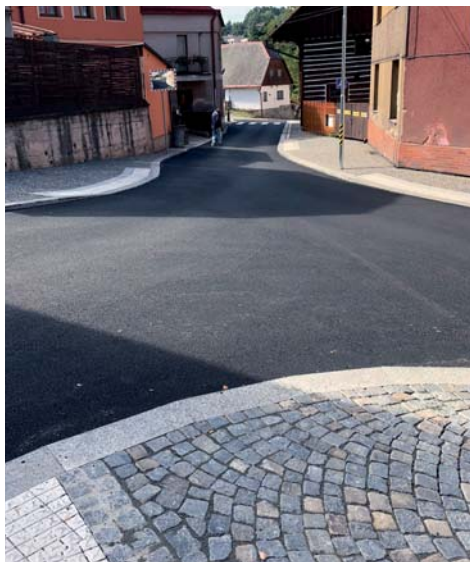
Ulice Prokopa Velikého, Úpice
